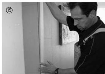
Nach der Verlegung werden bei Bedarf Außen- oder Innenecken an der Wand befestigt – fertig. Im Bereich von Schrauben oder anderen Befestigungssystemen (zum Beispiel beim Befestigen von Bilderrahmen und Mobiliar) ist auf einen umlaufenden Dehnungsabstand von min. 5 mm zu achten.
