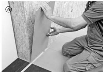
An der linken unteren Wand beginnend wird das erste Element so aufgesetzt, dass sich die Nutlängsseite auf der rechten Seite befindet. Sollen die Elemente im Querformat angebracht werden, muss die Nutlängsseite nach oben zeigen. Dehnungsabstand zum Boden oder Raumecken: mindestens 5 mm. In den folgenden Bildern erfolgt die Verlegung der Elemente in Hochformat.
