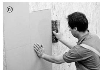
Bei Bedarf kann die Reihe mit Hilfe eines Schlagklotzes begradigt werden. Dieser Vorgang sorgt u. a. auch für einen perfekten Fugenschluss.
