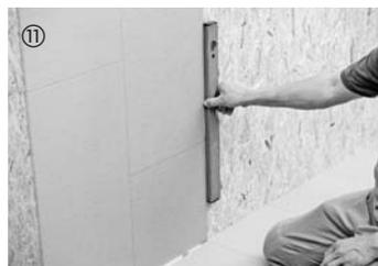
Die senkrechte oder waagerechte Einstellung mit Wasserwaage oder Richtschnur kontrollieren.
