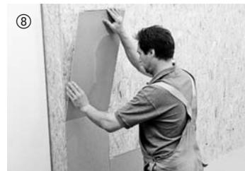
Das zweite Element der ersten Reihe ist nach dem Kleberauftrag erst an der Stirnseite in das erste Element einzuklicken, abzusenken und anzudrücken.
