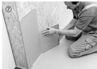
Das vorgeschchnittene nächste Element wird nach dem Kleberauftrag im Halbdiehlenversatz erst an der Längsseite in das erste Element eingewickelt und anschließend angegedrückt.
