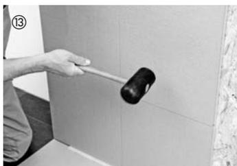
Die CELENIO Elemente werden mit Hilfe des Gummihammers fixiert und somit die Benetzung mit dem Kleber gewährleistet.
