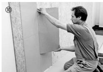
Das zweite Element der zweiten Reihe ist erst auf der Längsseite einzuwickeln und anschließend an den Kopfen von oben in die vorherige Diele einzuklicken. Beachten Sie hierbei, dass das Element stirnseitig an das zuvor verlegte Element anstößt. Durch kurzen Druck auf den Querstoß rastet das Element ein.
